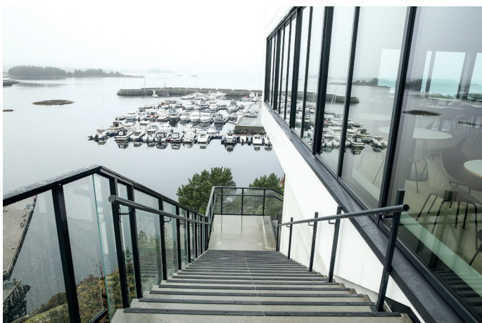
Fra terrassen med inngang til kantinen i 2.-etasje er det trapp ned på utsiden mot sjøen. Vi ser småbåthavna er nærmeste nabo på utsiden.
