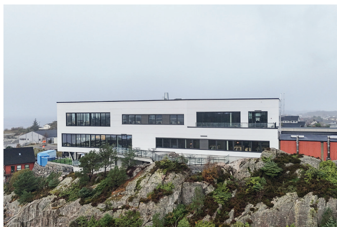
Administrasjonsbygget til Nor Tekstil sett fra vest. Det ligger fint til på en klippe mot sjøen i et industriområde på Havreneset rett vest for Florø sentrum. Det er utgang fra kantinen til terrassen i 2. etasje.
